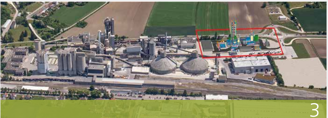
3. LA CEMENTERIA DI MERGESTETTEN DEL GRUPPO SCHWENK CON L'IMPIANTO PILOTA NEL RIQUADRO / THE MERGESTETTEN CEMENT PLANT (SCHWENK GROUP) WITH THE PILOT PLANT IN THE SIDEBAR
